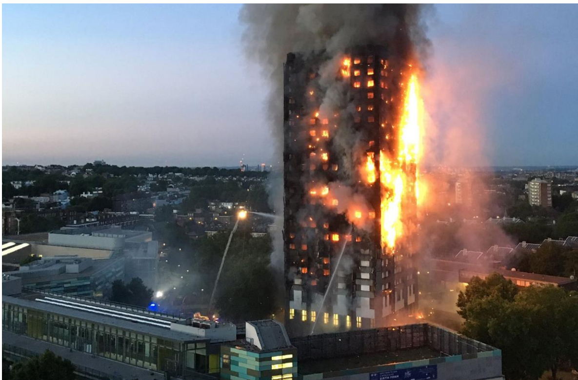
■写真 炎上する Grenfell Tower
